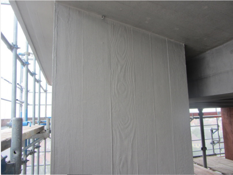
Oberflächenschutz mittels Schlämmglasur
